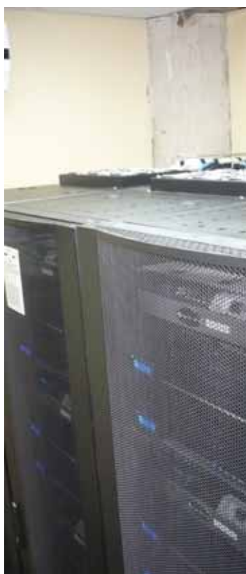
En la central, se instalaron los grabadores de video en red, el sistema de almacenamiento principal y el de respaldo.
