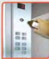
MANTENIMIENTO DE ASCENSORES
