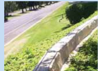
Cable sensor sobre muro
