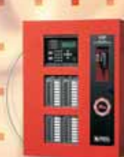
Panel de alarma con sistema de evacuación por voz
