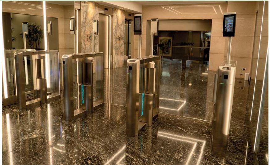
La pasarela motorizada utilizada en la implementación del proyecto es un producto desarrollado y fabricado en Argentina con materiales de calidad. Versátil, confiable y compatible con la integración de las tecnologías clave de identificación: reconocimiento facial, biometría, RFID y lectura de código QR/DNI.
