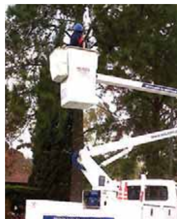
Hidroelevador de USS realizando tareas de mantenimiento.
